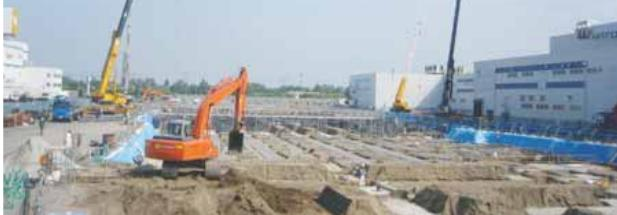
■ 基礎工事(掘削、鋼矢板等打込み)
